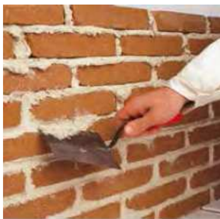
Murovanie spojovacou väzbou
